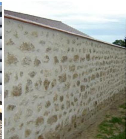
figuré 1 : haie vive, figuré 2 : mur bahut et dispositif à claire-voie, figuré 3 : mur en moellon
