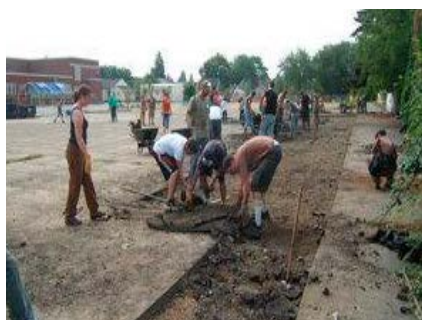
Exemple de desimpermabilisation
